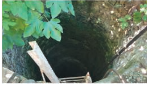
Şekil 10. Yedikule'de Malcı Çırağı Mehmet Paşa Camii'nin yanındaki bostanın yuvarlak planlı 6 metre çapında 30-40 metre derinliğindeki taş örgü bostan kuyusu (İnanç Kıran, 2018)
